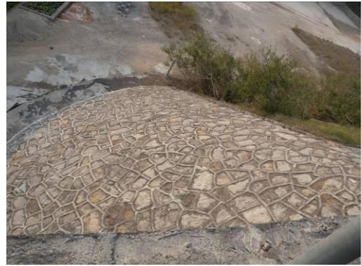
隧道口菱形骨架护坡
