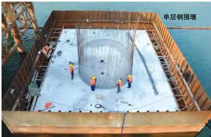
图 2.5-6 钢围堰典型施工图
